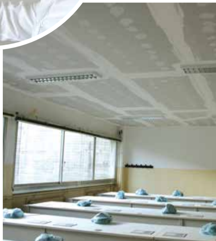
Controsoffitto antisfondellamento completato in attesa di tinteggiatura
