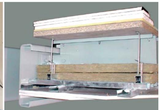
Fig. 13 - Esempio di solaio interpiano stratificato a secco. Chignolo d'Isola (BG), 1999
