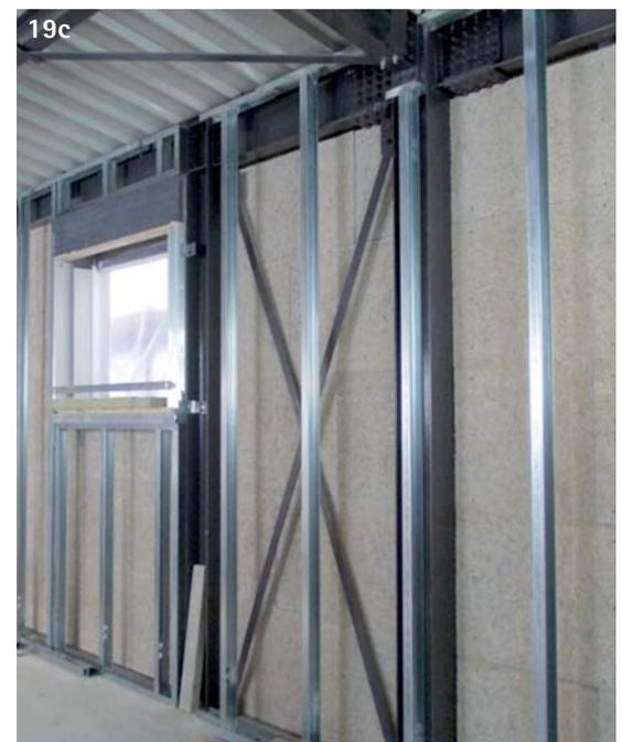
Fig. 19a, 19b e 19c - Pacchetto d'involucro verticale perimetrale
