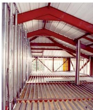
Fig. 2 - Primo sopralzo a secco in Italia. Bergamo, Via Lapacano, 1990
