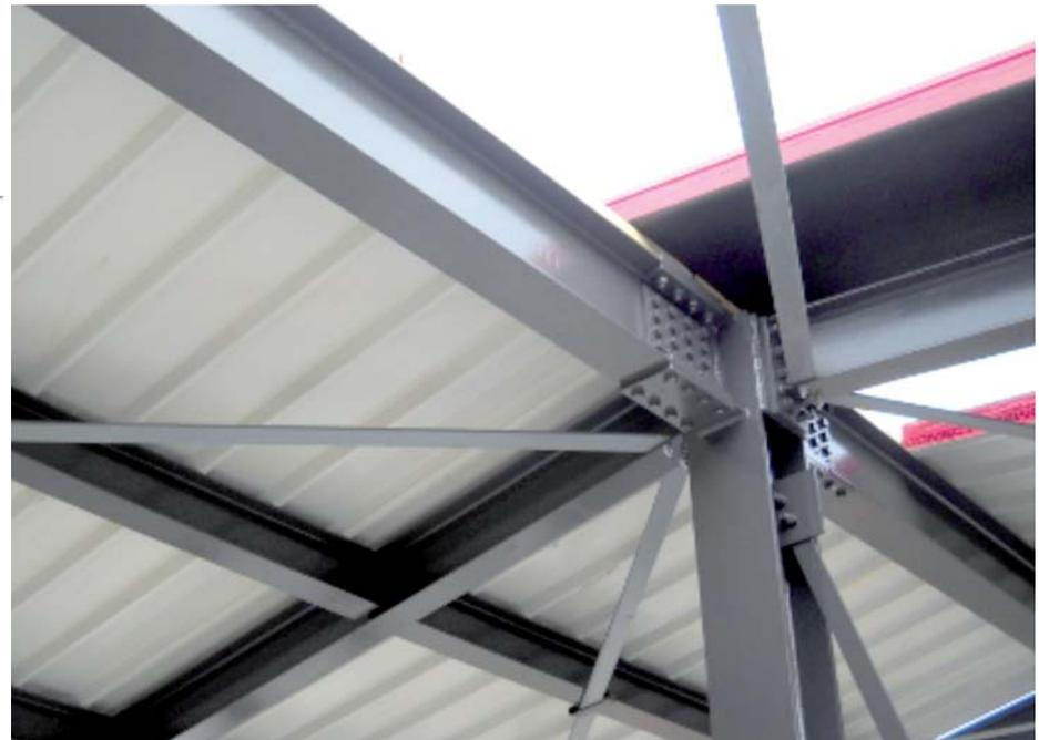
Fig. 18 - Intradosso copertura "al grezzo" tra struttura portante e primo strato in pannelli sandwich
