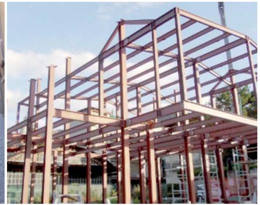
Fig. 16 - Telaio strutturale in carpenteria laminata a caldo
