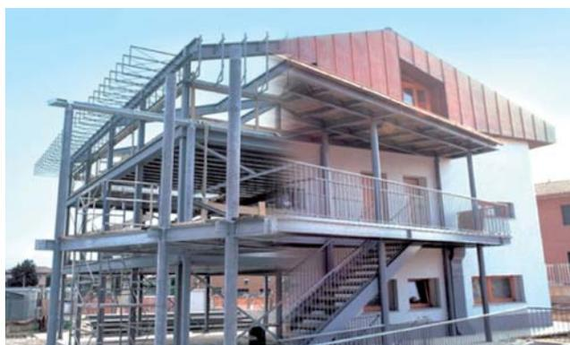
Fig. 3 - Primo edificio "passivo" plurifamiliare con struttura in acciaio. Chignolo d'Isola (BG), 1999
