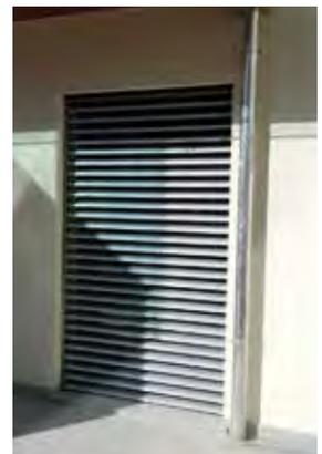
La protezione estiva ai raggi solari è un tema da considerare per tutte le parti finestrate. In queste foto possiamo apprezzare frangisole scorrevoli in legno, sporti di gronda e tapparelle a lamelle che, ruotando intorno al loro asse, permettono ai clienti di "dosare" la quantità di sole senza essere costretti a privarsi della luce naturale.
